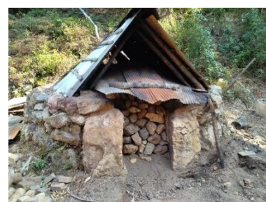
⑦炭焼き窯(覆盆子橋を渡りすぐ左)
