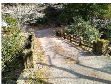
⑥覆盆子橋(昭和38年3月架換)
