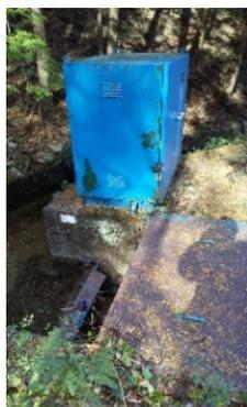
⑨洪水時に転倒ゲートのステンレス製のシリンダーが下に作動しゲートが倒れる(前方中央にゲートのシリンダーがある)
