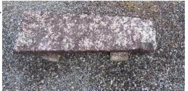
④トンネルに使用された三河産の花崗岩の石材の一部(長さ約1m)
