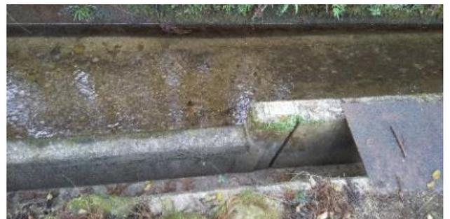
⑥「うてび」(上側が用水路)、水量が多いときは下側の水路で横輪川にもどします
