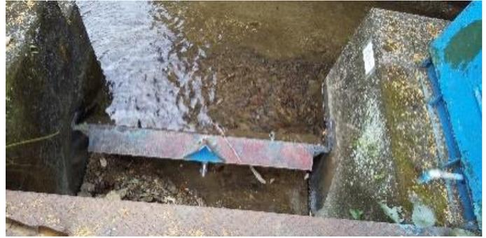
⑨洪水(こうずい)時に、転倒ゲートのステンレス製のシリンダーが下に動いてゲートが倒れます。前方中央にゲートのシリンダーがあります。
