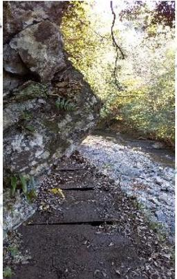
⑦前方に大きい岩。土砂と落ち葉の流入を防ぐために鉄板が敷かれている
