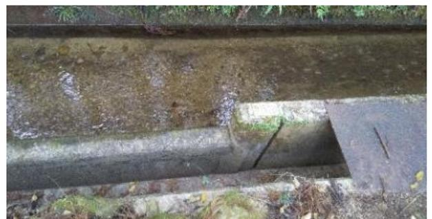
⑥第1うてび(上側が用水路)、水量が多いときは下側の水路で横輪川に戻す
