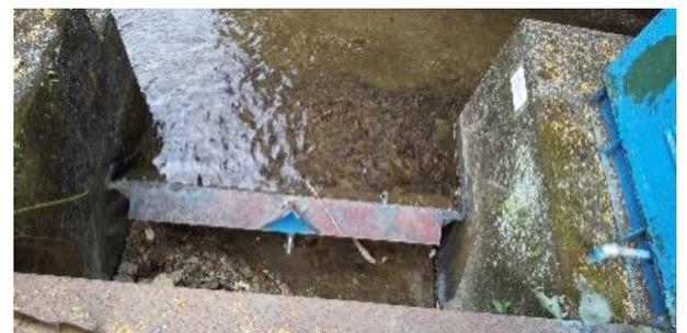
⑧転倒ゲート:洪水時に転倒ゲートのステンレス製のシリンダーが下に作動しゲートが倒れる(前方中央にシリンダーがある)
